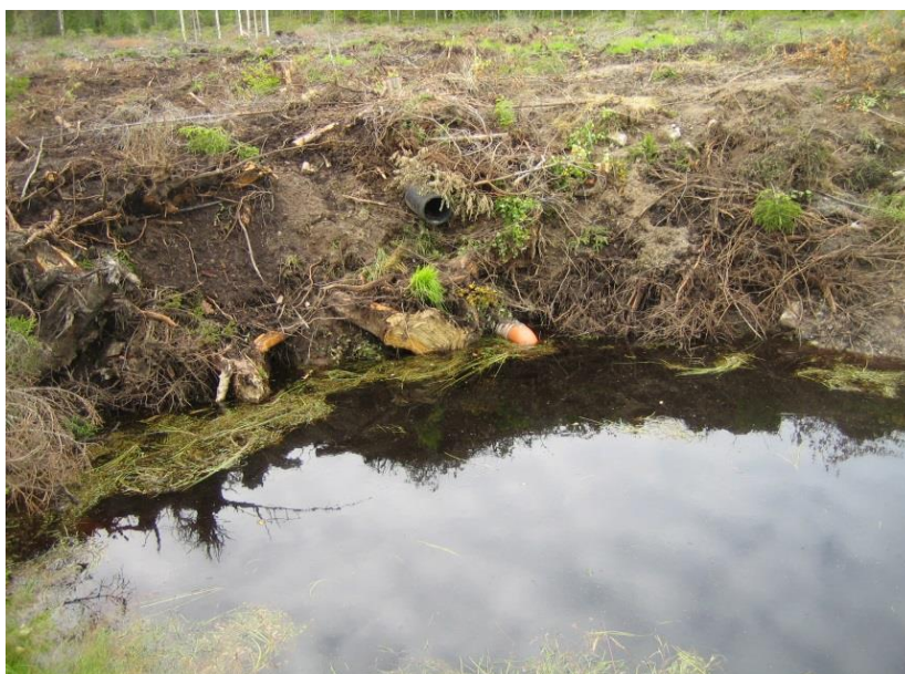
Zdjęcie 8. Konstrukcja do regulowania odpływu w Finlandii. Dolna rura jest pomarańczowa, a górna czarna. Fot.: Antti Leinonen
