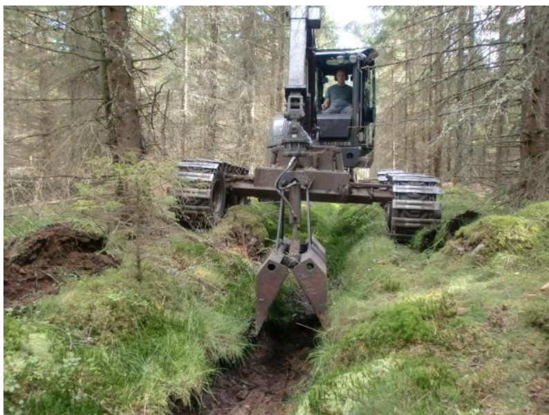
Zdjęcie 1. Nowoczesny sprzęt „Varanen” do prowadzenia czynności utrzymaniowych sieci rowów melioracyjnych w Szwecji. Fot.: Anja Lomander
