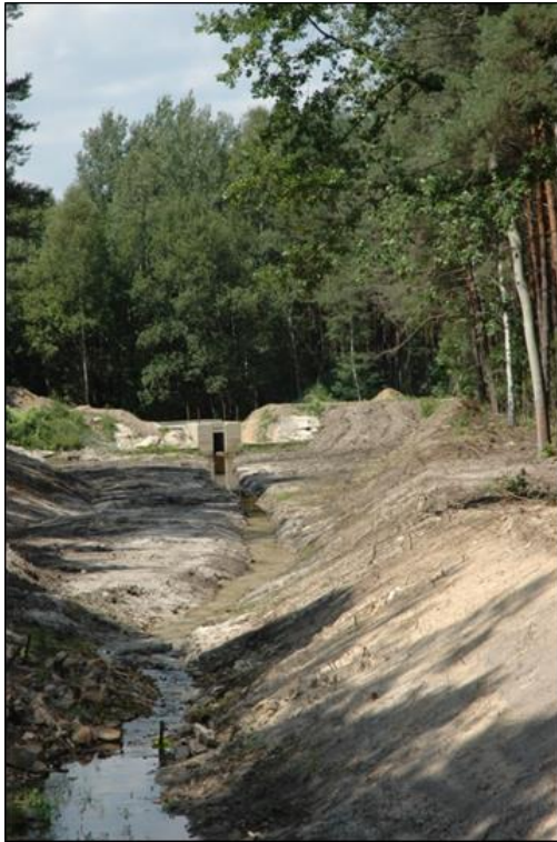
3 pav. Hidromelioracijos sistemoje instaliuota vandens sulaikymo užtvanka Lenkijoje (nuotraukos autorius Wojciech Gil)
