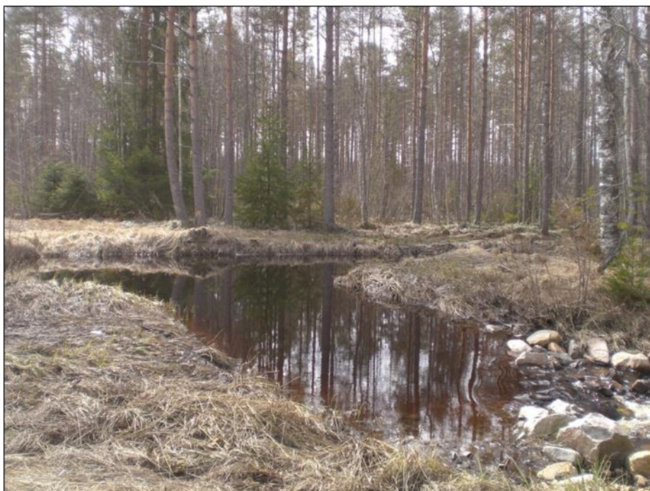
5 pav. Sedimentacijos tvenkinys ir akmeninė užtvara Suomijoje (nuotraukos autorius Leena Finér)
