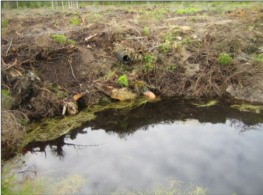
8 pav. Kontroliuojamasis drenažas Suomijoje. Paveiksle matyti oranžinis ir juodas vamzdžiai (nuotraukos autorius Antti Leinonen)
