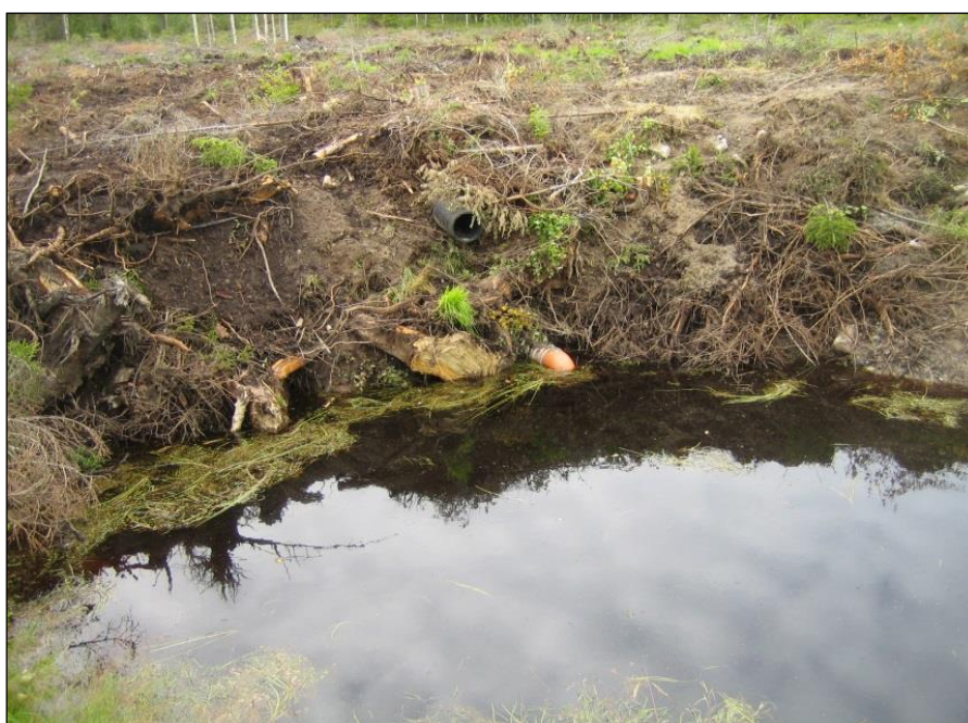
8.attēls. Maksimālās noteces kontroles struktūra Somijā. Zemāk novietotā caurule ir oranžā krāsā, bet augstāk novietotā – melnā krāsā. Foto: Antti Leinonen.
