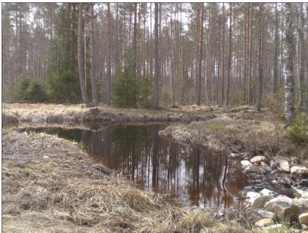
5. attēls. Sedimentācijas dīķis un no akmeņiem veidots dambis Somijā. Foto: Leena Finér.
