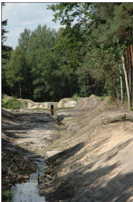
3.attēls. Dambis ūdens aiztures nodrošināšanai meliorācijas sistēmā Polijā. Foto: Wojciech Gil
