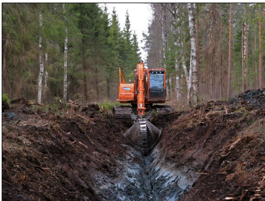
Kuva 12. Kunnostusojitusta Suomessa. Kuva: Markku Saarinen.
