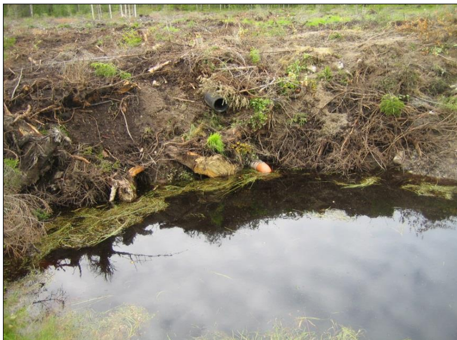
Kuva 8. Virtaamansäätöpato eli putkipatorakennelma Suomessa, alemman säätöputken mutka näkyy oranssina vesirajassa ja ylempi musta säätöputki sen yläpuolella. Kuva: Antti Leinonen.
