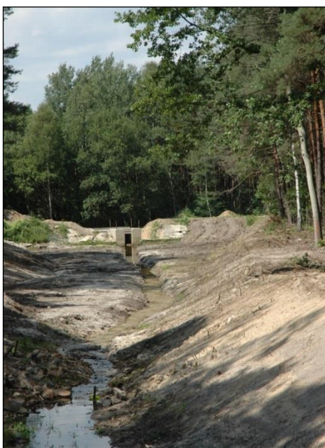
Kuva 3. Patorakennelma ojastossa, jonka tarkoitus on varastoida vettä metsäalueelle Puolassa. Kuva: Wojciech Gil.
