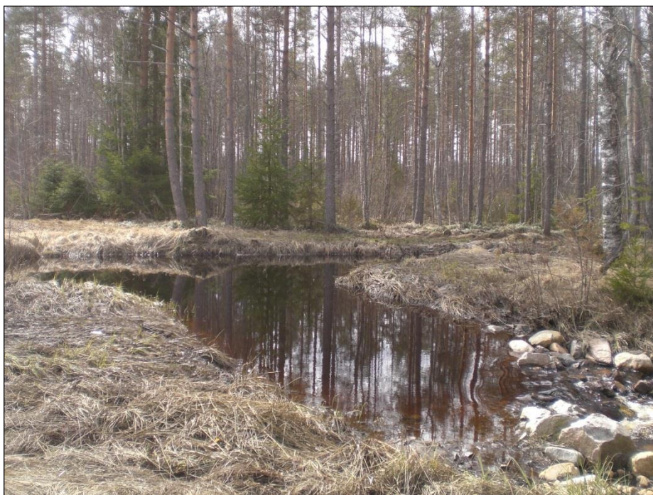
Figur 5. Sedimentationsdamm med en dammvall byggd av stenar i Finland. Inflödet är uppifrån till höger, och dammen har en utbuktning i bildens övre vänstra hörn, i vilket uppehållstiden för vattnet förlängs. Att bygga dämnet av stenar gör att det armeras bättre och risken för erosion minskar. Det är inte alltid det finns gott om sten på platsen att bygga dämme av, men ibland går det. Foto: Leena Finér.
