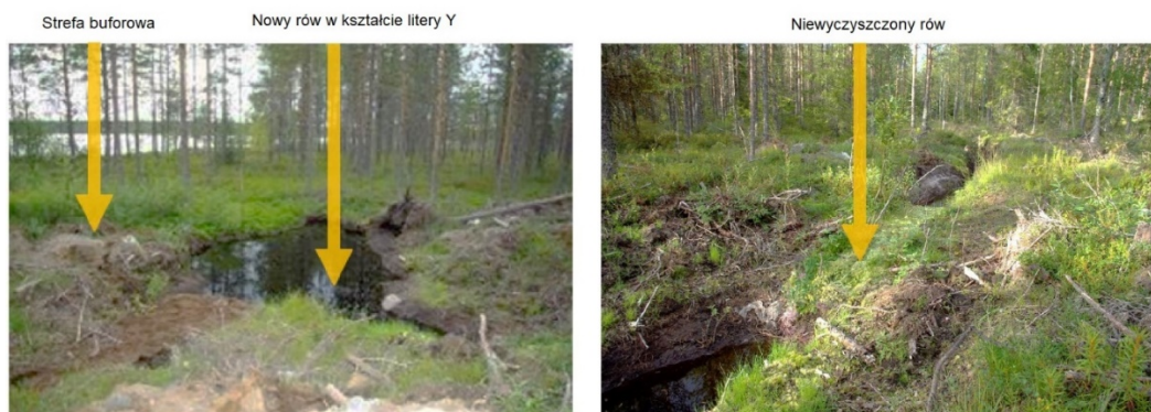
Rys.16. Nowy rozwidlony rów (kształt Y) do rozprowadzenia wody do mokradłowej strefy buforowej w Finlandii (po lewej) i nieoczyszczona część rowu (po prawej). Zdjęcia: Eva Ring.
