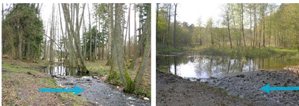
Rys.26. Progi z przepławkami „zbliżonymi do naturalnych”, nazywane rampami dennymi i pochyleniami dennymi. Ich próg ma szorstką powierzchnię i rozciąga się na całej szerokości rzeki z jak najmniejszym nachyleniem, aby przewyciężyć różnicę poziomów dna rzeki (FAO.2002). Zdjęcie: Andrzej Ryś.
