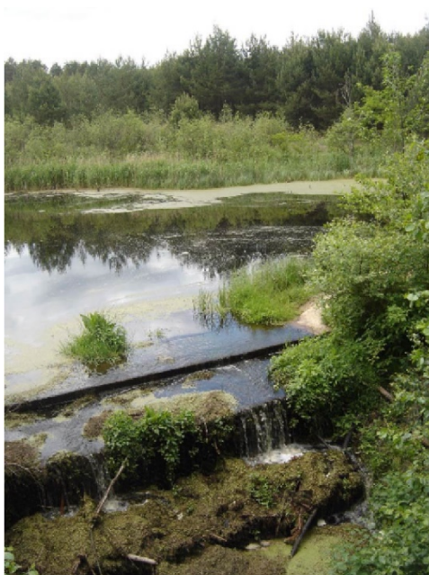
Rys. 32. Próg gabionowy odpływu wody ze zbiornika w Polsce. Zdjęcie: Edward Pierzgalski.
