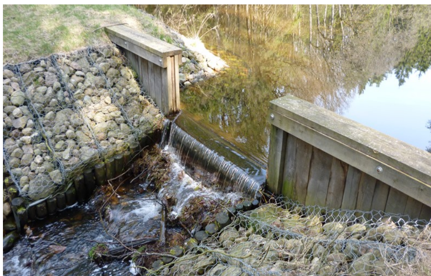
Rys.29. Zastawka zbudowana w cieku wodnym w celu kontrolowania poziomu wody. Zdjęcie: Michał Wróbel.
