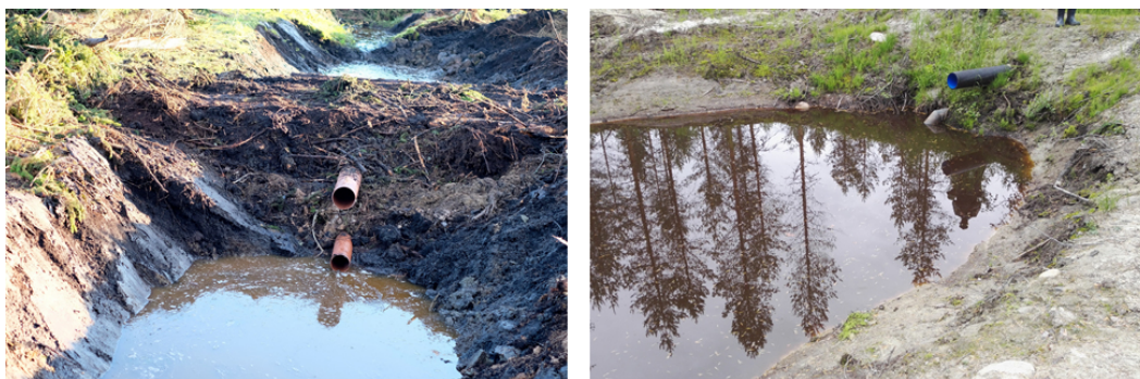
Rys. 8. Obiekty kontroli kulminacyjnego przepływu w dwóch pokazowych obszarach WAMBAF. Należy zwrócić uwagę na dwie widoczne rury na zdjęciu z Tobo w środkowej Szwecji (po lewej). Zdjęcie: Lars Högbom. Na prawym zdjęciu (obiekt w Vengasoja w środkowej Finlandii) widoczna jest górna awaryjna rura przelewowa, a reduktor przymocowany do rury kontroli odpływu znajduje się poniżej powierzchni wody. Zdjęcie: Leena Finér.
