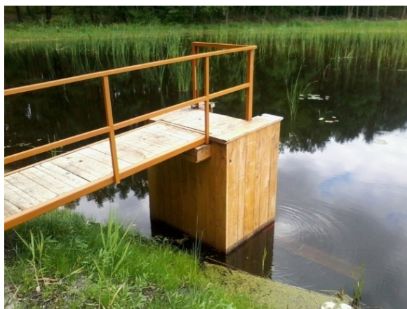
Rys. 33. Budowle (mnichy) regulujące odpływ wody ze zbiorników. Zdjęcie: Michał Wróbel.
