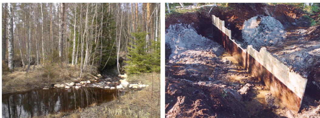
Rys. 6. Po lewej działający bystrotok. Zdjęcie: Leena Finér. Po prawej stronie budowana ściana szczelna: umieszczona jest pośrodku progu w poprzek rowu, gdzie przewidywana jest wysoka prędkość przepływu wody. Zdjęcie: Matti Seppälä.
