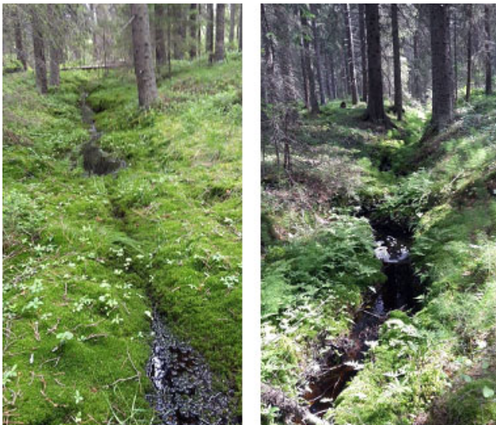
Rys.4. Przykłady rowu odwadniającego (po lewej) i rowu zbiorczego (po prawej) w miejscach, w których wykonanie rowów przyczyniło się do wzrostu lasów w Szwecji. Niektóre odcinki rowów pozostawiono nieoczyszczone, a doły sedymentacyjne wykopano co 100-200 metrów wzdłuż rowów. Zdjęcia: Bo Leijon.
