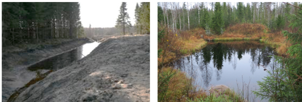
Rys. 17. Po lewej nowo wybudowany staw sedimentacyjny na Łotwie (zdjęcie: Zane Libiete), po prawej 20-letni staw sedimentacyjny w środkowej Finlandii. Zdjęcie: Tommi Tenhola.
