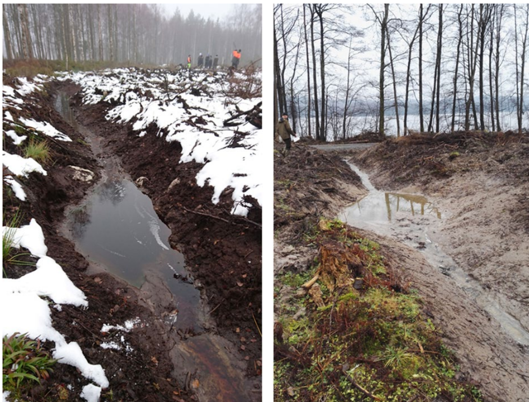
4 pav. Sedimentacijos duobės sausintuve pietų Švedijoje. Nuotraukų autoriai: Eva Ring (nuotrauka kairėje) ir Anja Lomander (nuotrauka dešinėje).
