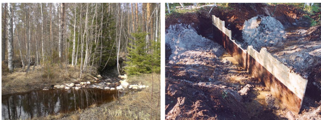
6 pav. Dugno užtvanka (kairėje). Nuotraukos autorius Leena Finér. Dešinėje nufotografuota atraminė siena: ji statoma griovio viduryje, kur vandens srovė yra didelė. Nuotraukos autorius Matti Seppälä.
