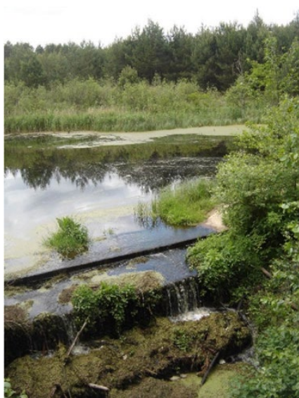
32 pav. Lieptelis (iš gabiono) skirtas vandens nutekėjimui iš rezervuaro. Nuotraukos autorius Edward Pierzgański.
