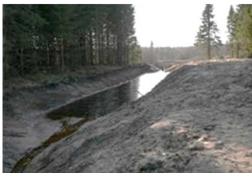
17 pav. Kairėje pavaizduotas naujai įrengtas sedimentacinis tvenkinys Latvijoje (nuotraukos autorius Zane Lībiete); dešinėje – prieš 20 metų įrengtas sedimentacinis tvenkinys centrinėje Suomijoje (nuotraukos autorius Tommi Tenhola).
