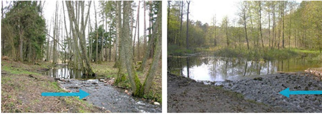
26 pav. Užtvankos su specialiais slenksčiais žuvims migruoti priklauso „artimo gamtai tipui“ ir turi rampą bei nuolydį. Slenkstis yra konstruojamas taip, kad tęstųsi per visa upės ar griovio plotį, kuo mažesniu nuolydžiu (FAO.2002). Nuotraukų autorius Andrzej Ryś.
