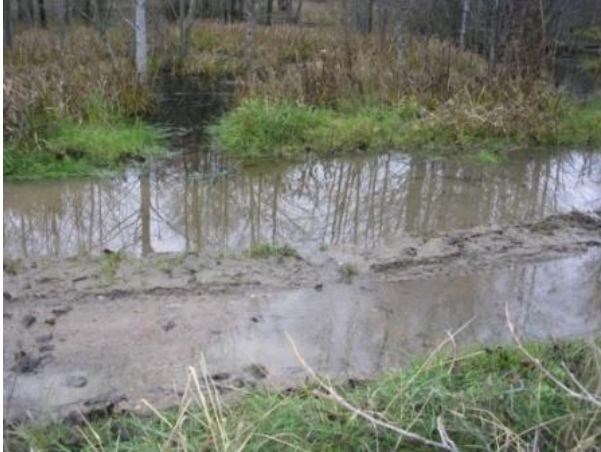
Fig. 7. Skogsväg som översvämmats pga. närheten till en bäverdamm (Litauen, ©Olgirda Belova)
