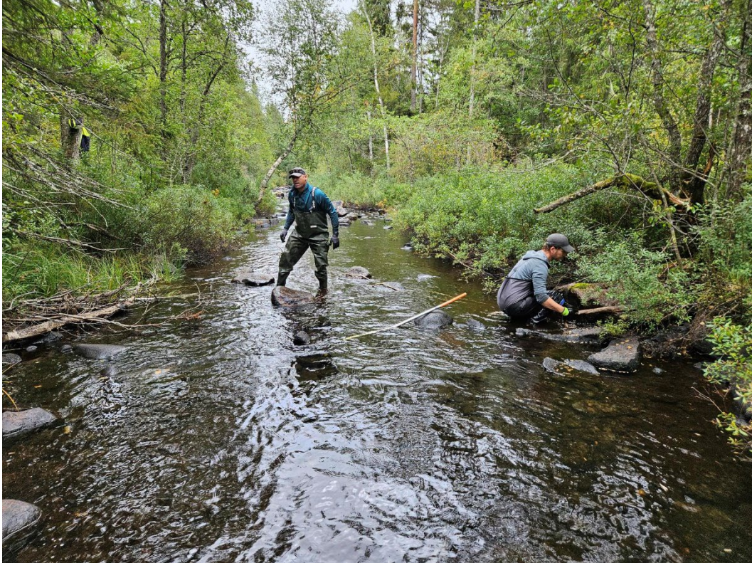
Bild 1. Pågående arbete med att flytta sten och block.
