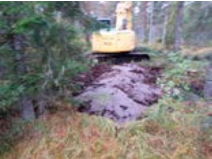
En plugg av torv har börjat byggas tvärs över ett av Djurgårdsmossens diken.
