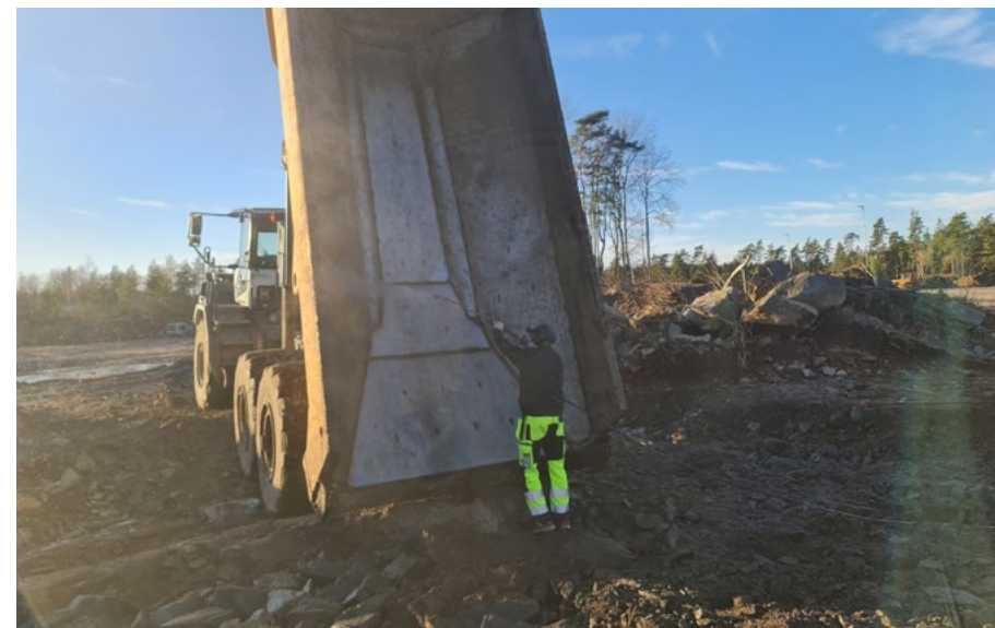
Rengöring av flak med högtryckstvätt.
