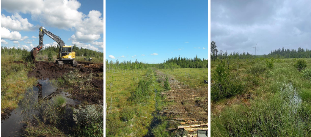
Figur 6. De två bilderna längst till vänster är tagna under restaureringen 2012 och bilden till höger är från 2024.
