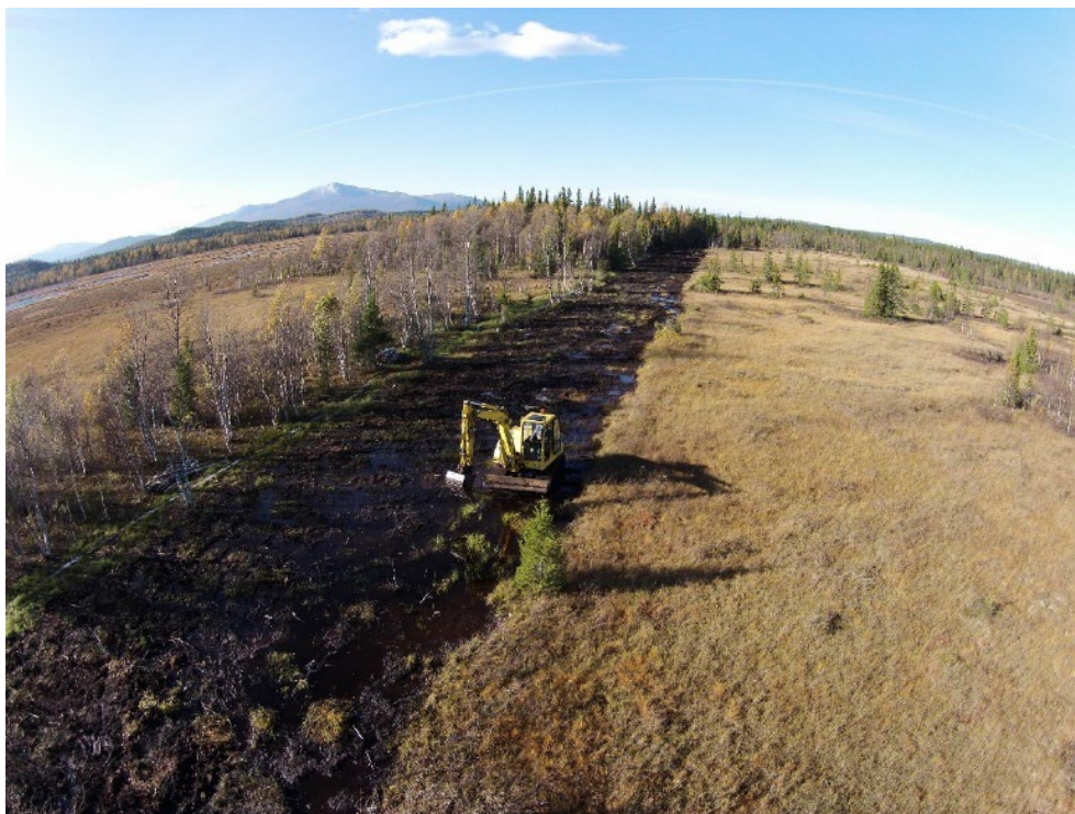
Figur 13. Foto över åtgärderna som utfördes på Ånnsjöns myrar, där det inte fanns torvvallar att ta material från för att fylla diken med torv.
