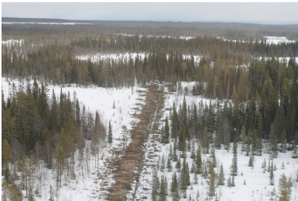
Figur 22. Dike innan igenläggningen 2012, avvercade träd har lagts bredvid diket för grävmaskinen att köra på under arbetet.
