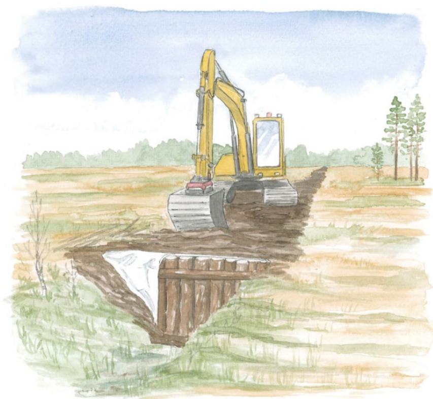
Figur 14. Illustration över hur pluggar i diken på Ånnsjöns myrar byggdes. Illustration Lotta Ström Länsstyrelsen i Västerbottens län.
