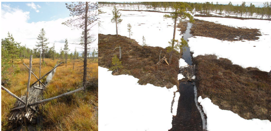
Figur 2. Pluggarna av björkris nyligen efter att de placerats i diken.
