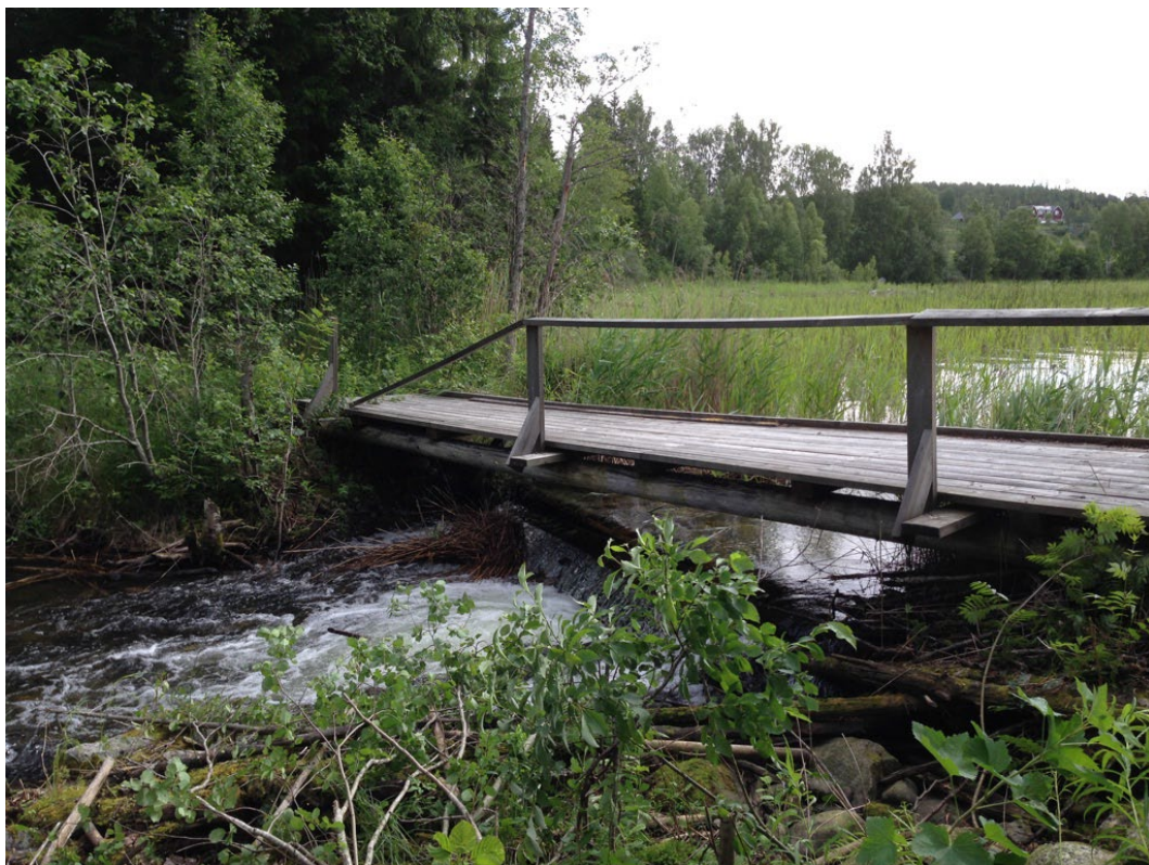
Figur 3. Bensjöån trätröskel före utrivning.
