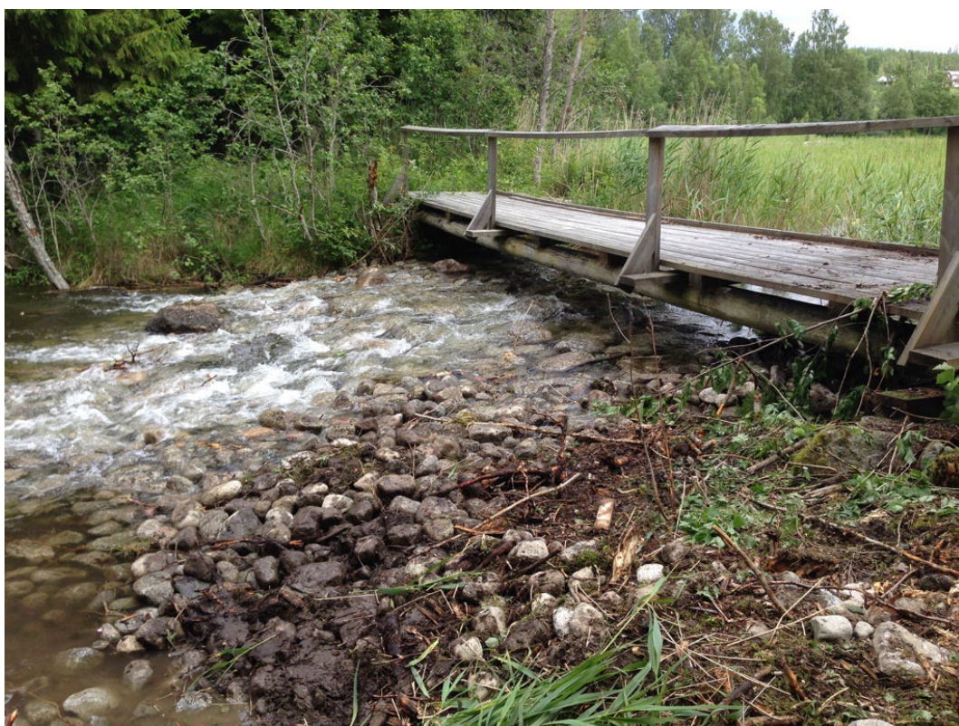
Figur 4. Bensjöån trätröskel efter utrivning.
