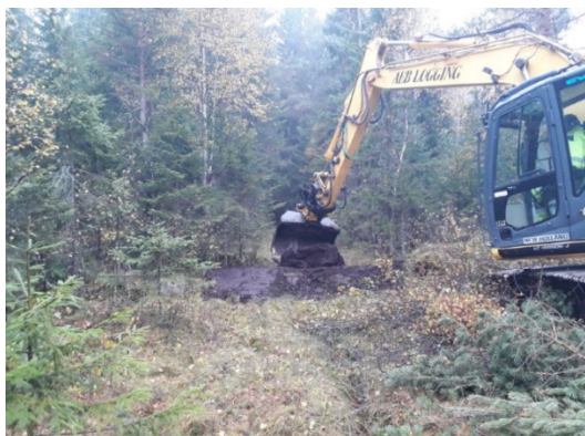
Bild 1 och 2. Till vänster byggs plugg av enbart torv. Till höger används en förstärkning av rundvirke tvärs diket. Rundvirket täckts helt med torv. Foto: Magnus Lindh
