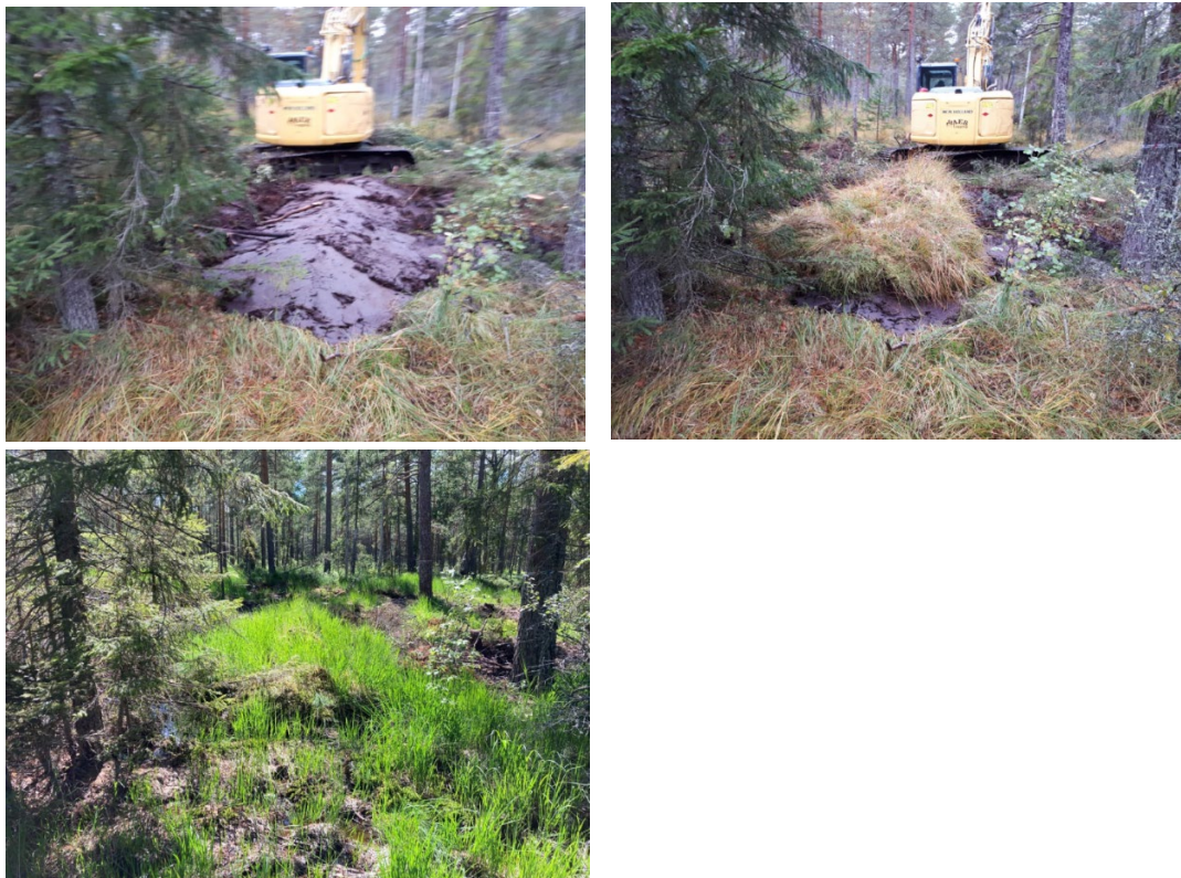
Bild 10, 11 och 12. Foton på en plugg med tvärgående vall. Första fotot med bar torv, andra fotot där vegetationstorvor lagts på och tredje fotot efter knappt ett år. Foto: Magnus Lindh
