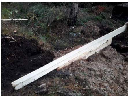
Bild 5 och 6. På bilden till vänster syns den liggande palissaden vid plugg A1. Palissaden täcktes sedan helt av mineraljord så att den blev cirka 0,5 meter högre än marken. Det var omständligt att använda liggande palissad och efter detta tillfälle används stående palissad i möjligaste mån. Till höger har samma plugg reparerats för hand och täckts med vegetationstorvor. Till vänster på den bilden syns partiet på kanten av pluggen som eroderat bort. Där har nu pluggen förstärkts och erosionsskydd med stenar lagts dit. Foto: Magnus Lindh
