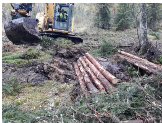
Bild 1 och 2. Till vänster byggs plugg av enbart torv. Till höger används en förstärkning av rundvirke tvärs diket. Rundvirket täckts helt med torv. Foto: Magnus Lindh
