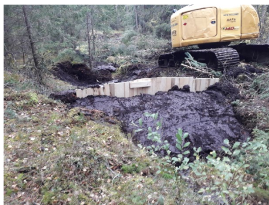
Bild 3 och 4. Till vänster läggs diket igen med torv. Det täcks sedan med vegetationstorvor eller strösslager för att gynna vegetationsetablering. Till höger syns plankpalissaden på sista pluggen. Hela palissaden täcks sedan med torv och byggs cirka 0,5 m högre än omgivande mark. Foto: Magnus Lindh
