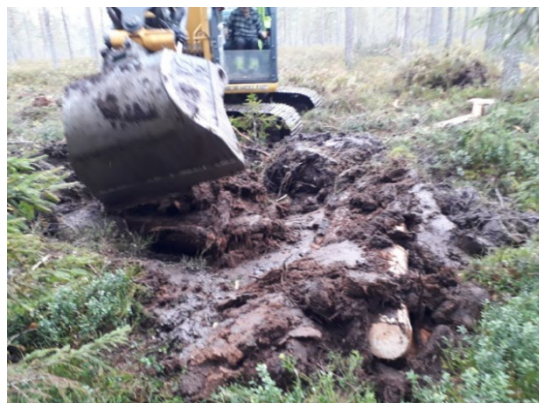
Bild 7 och 8. Tvärs över diket grävs en "grav" djupare än diket och bredare än diket. Virke läggs i för att stabilisera pluggen. Torv packas runt virket. Foto: Magnus Lindh
