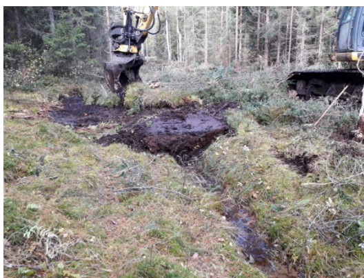
Bild 3 och 4. Till vänster läggs diket igen med torv. Det täcks sedan med vegetationstorvor eller strösslager för att gynna vegetationsetablering. Till höger syns plankpalissaden på sista pluggen. Hela palissaden täcks sedan med torv och byggs cirka 0,5 m högre än omgivande mark. Foto: Magnus Lindh
