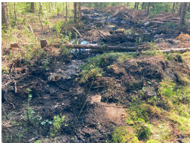
Bild 5 och 6. På bilden till vänster syns den liggande palissaden vid plugg A1. Palissaden täcktes sedan helt av mineraljord så att den blev cirka 0,5 meter högre än marken. Det var omständligt att använda liggande palissad och efter detta tillfälle används stående palissad i möjligaste mån. Till höger har samma plugg reparerats för hand och täckts med vegetationstorvor. Till vänster på den bilden syns partiet på kanten av pluggen som eroderat bort. Där har nu pluggen förstärkts och erosionsskydd med stenar lagts dit. Foto: Magnus Lindh
