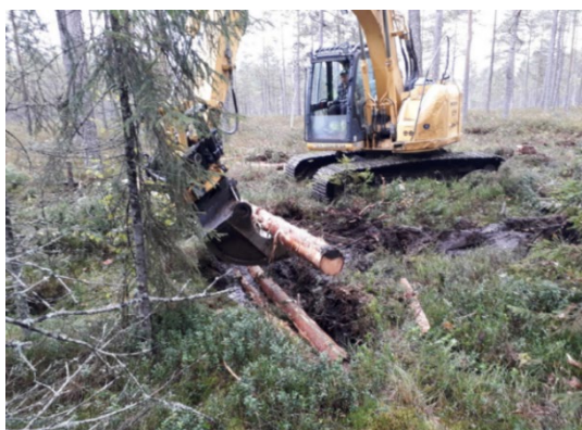
Bild 7 och 8. Tvärs över diket grävs en "grav" djupare än diket och bredare än diket. Virke läggs i för att stabilisera pluggen. Torv packas runt virket. Foto: Magnus Lindh
