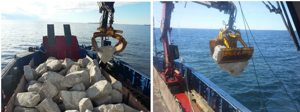
Figur 26. Sprängsten som används för att anlägga revet. Foto: Per-Olof Samuelsson.
