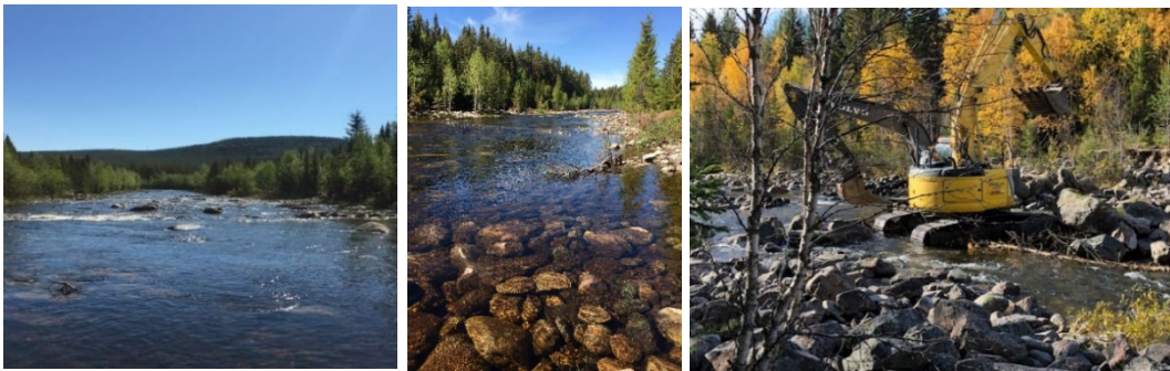
Figur 7. Vänstra och mellersta bilden visar Långålusnan. Höger bild visar två grävmaskiner som lägger ut sten i älvfäran. Foto: Projekt Långåfisket.
