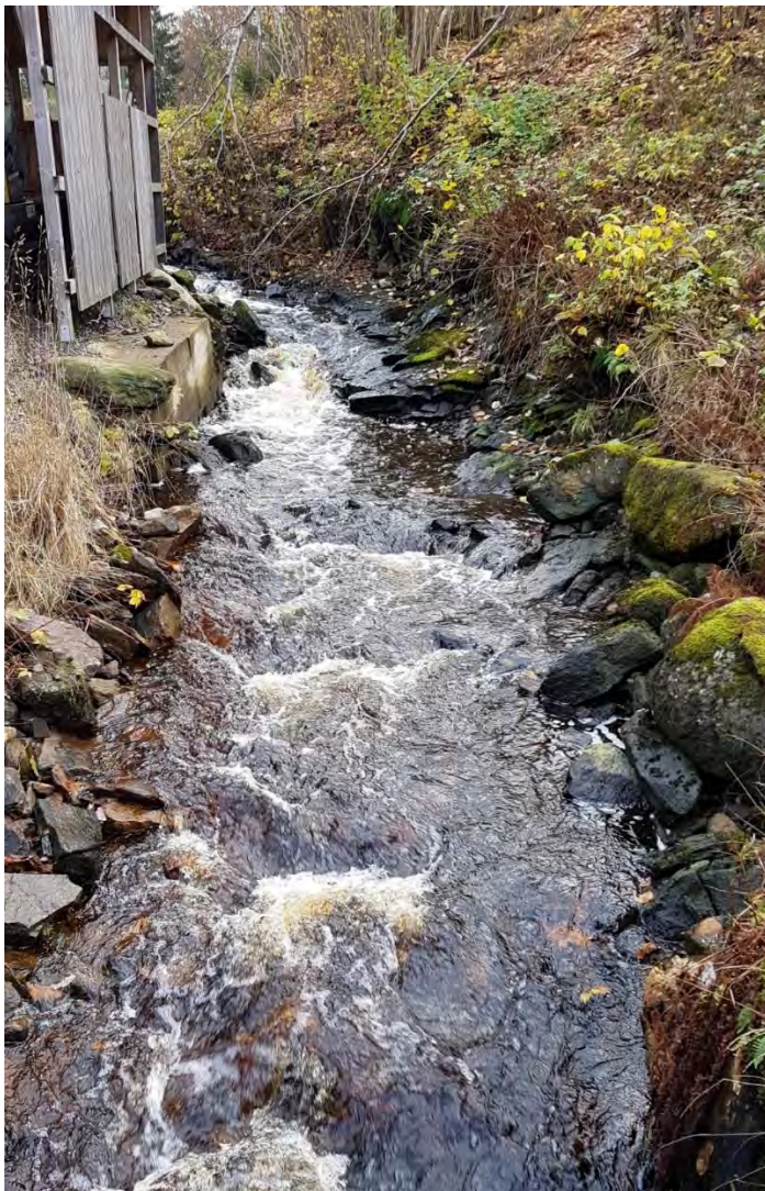
Figur 112: Kraftigt rensad sträcka som är i behov av biotopvård (sträcka 15).
