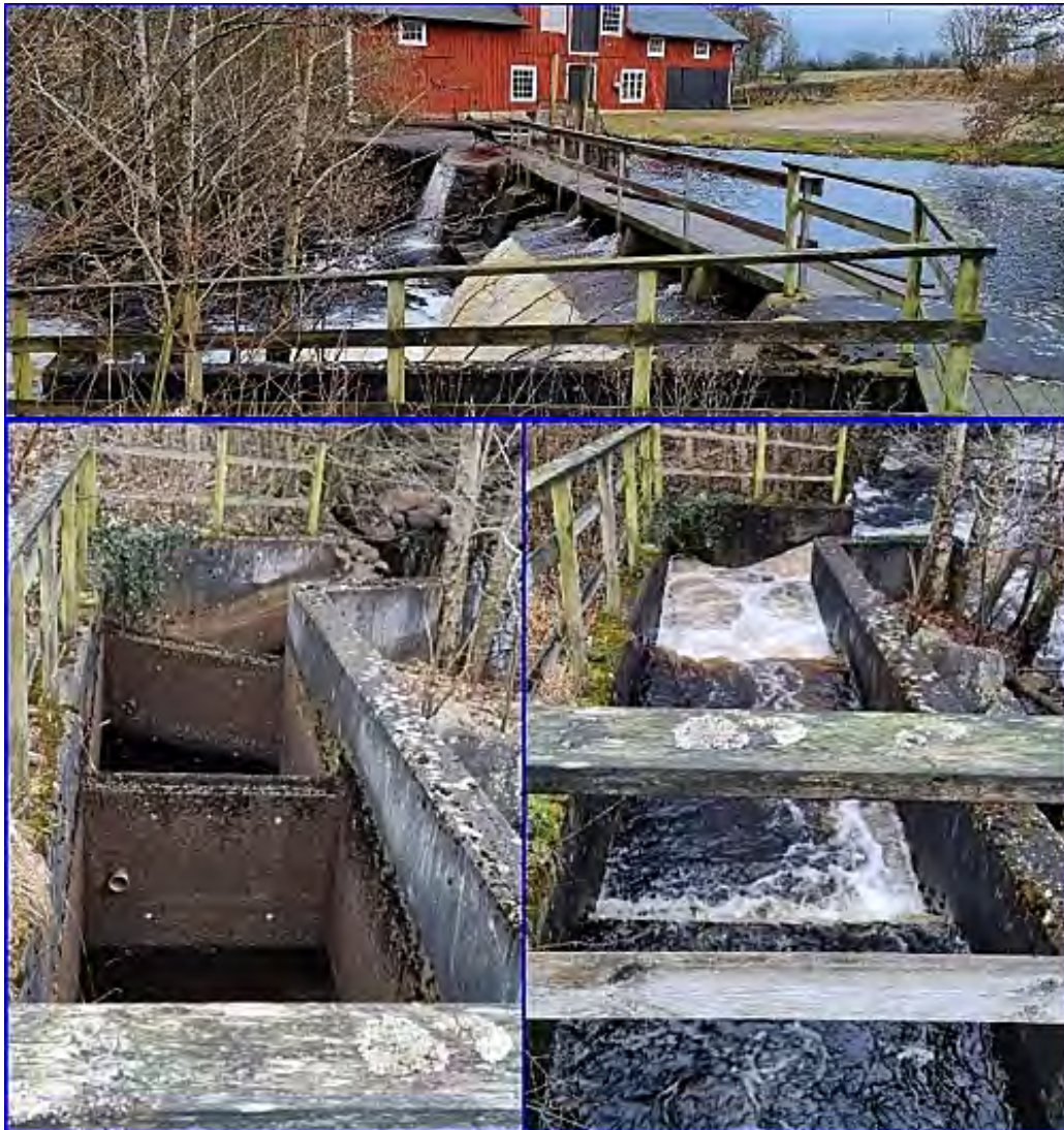
Figur 29: Övre bilden visar vandringshinder 2, Lindoms kvarn. Undre bilden till vänster visar fiskvägen vid två olika flöden. Den vänstra bilden togs 24/3 - 2021 och den högra bilden 1/4 - 2021.
