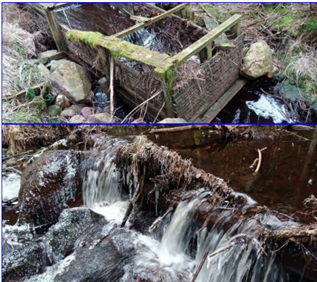
Figur 126: Exempel på vandringshinder i Svartavadsbäcken. Övre bilden visar ett onaturligt vandringshinder i form av ålkista (3). Nedre bilden visar naturligt vandringshinder i form av klippor och död ved (2).
