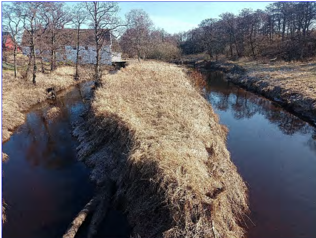
Figur 10: Sträcka 6 nedströms Tönnersa kvarn är omgrävd och uppdelad i två fåror varav den ena leds genom kraftverket.
