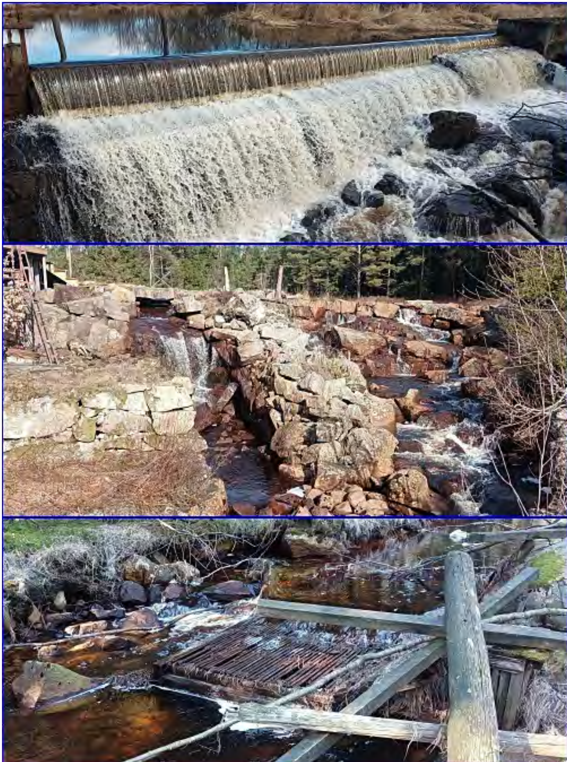
Figur 16: Exempel på vandringshinder i Genevadsån/Brostorpsån. Övre bilden till vänster visar Öringe mölla (1). Mittersta bilden till visar en uppdämd damm vid ett naturligt fall (5). Nedersta bilden visar en gammal ålkista (6).
