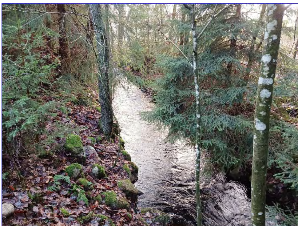
Figur 78: Omgrävd/rätad sträcka (sträcka 3). Notera fårans höga kanter och rikligheten av block och sten upplagt längs kanterna. Naturliga strukturer i form av block, sten och död ved är sparsamma i fårån som också är smalare än naturligt. Sträckan saknar helt översvämningssytor.
