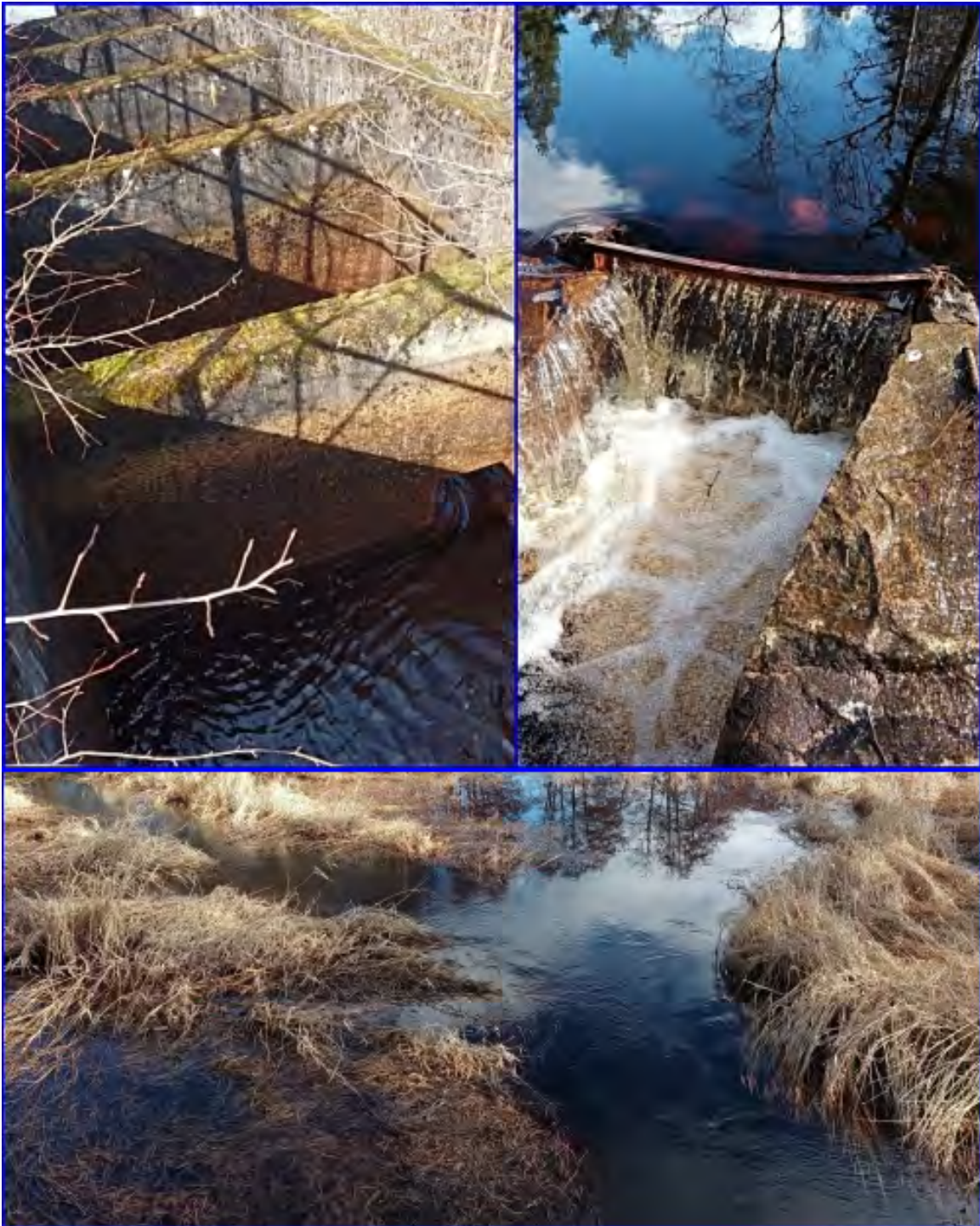
Figur 17: Bilden längst upp till vänster visar laxtrappan i Öringe mölla. Bilden längst upp till höger visar mittrännan som justeras manuellt vid dämningen uppströms Allareds mölla. Nedersta bilden visar inloppet till laxtrappa i Öringe mölla som håller på att växa igen.
