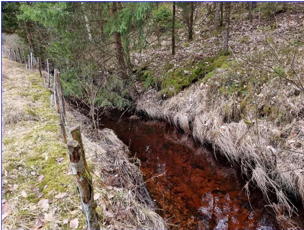
Figur 100: Omgrävd sträcka som vore lämplig att återmeandra till sin naturliga fåra (sträcka 25).
