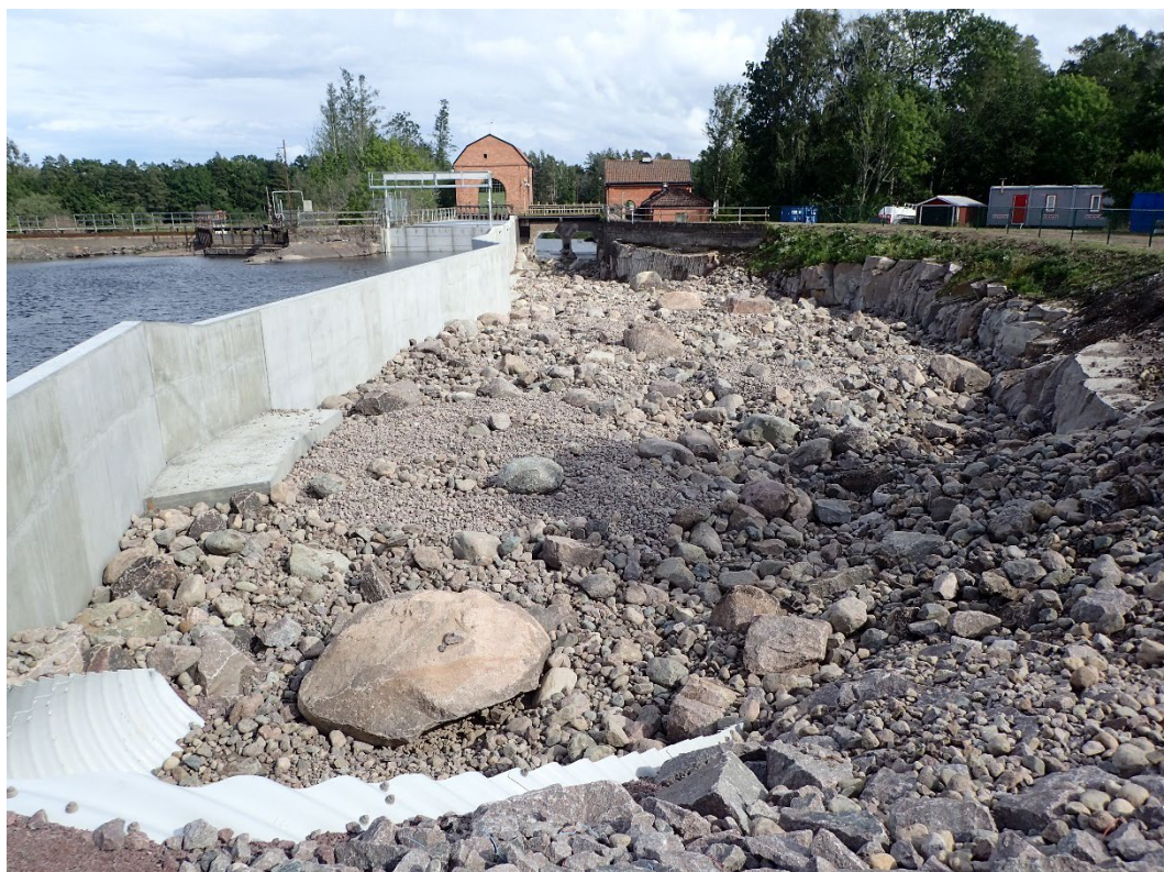
Figur 10: Nyligen anlagd faunapassage vid Karlshammar i Emån, innan vattnet släppts på. Ett exempel på en åtgärd som görs för att bland annat förbättra för fisk i vattendraget och som kommer av intresse för fisk och fiske. Fältbesök 2020-09-02.
