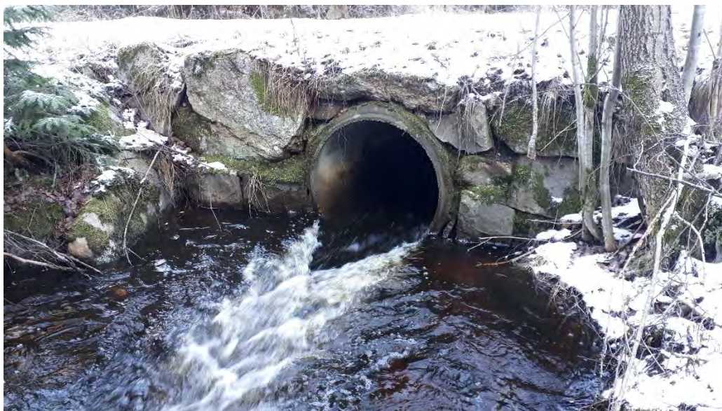
Figur 105. Vägtrumma utmed sträcka 20 i Påkamålabäcken. Foto: Jonathan Bark
