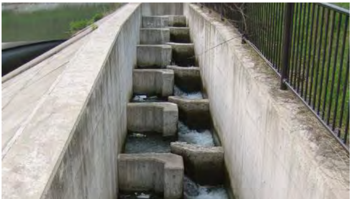
Figur 31. Exempel på slitsränna. Källa: Wikipedia
