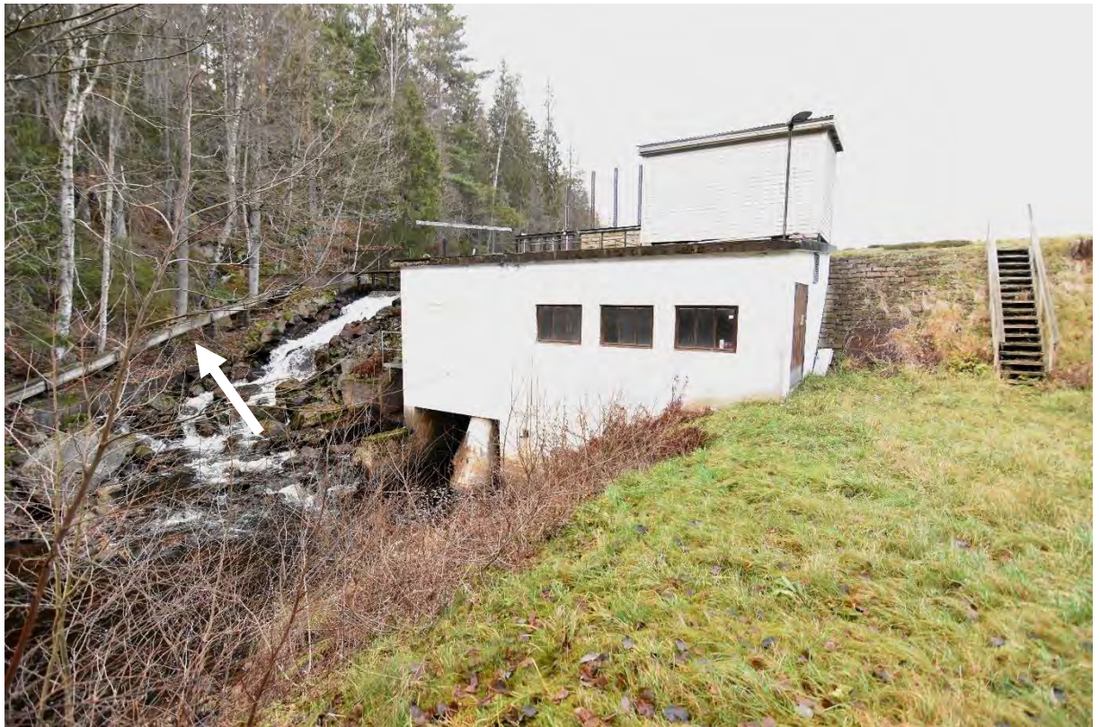
Figur 78. Dalfors kraftverk. Ålyngelledare finns (vit pil) men oklart om den är i bruk. Foto: Jonathan Bark
