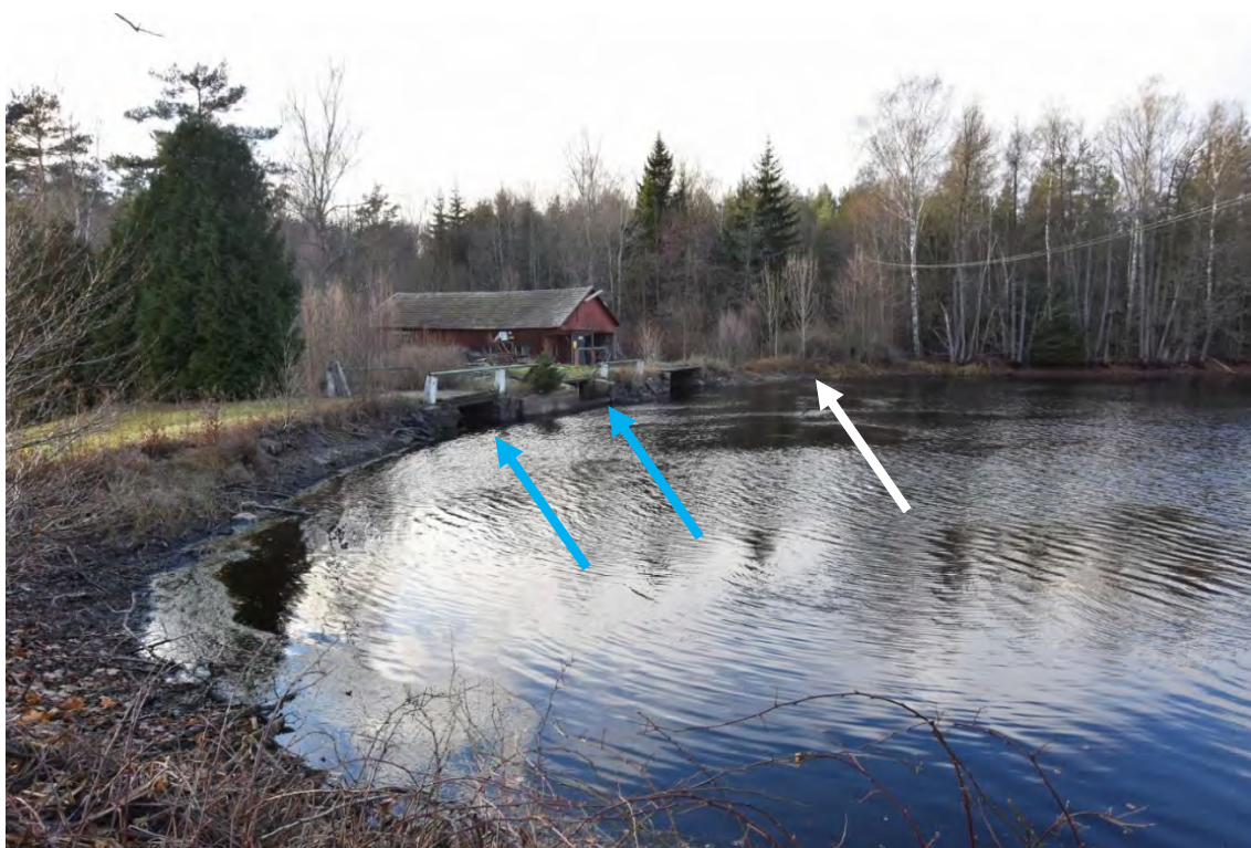
Figur 63. Norrefors kvarn och såg i Mieån, sett uppströms ifrån (från östra stranden). Blåa pilar: dammluckorna, vit pil: det avstängda omlöpet. Foto: Jonathan Bark
