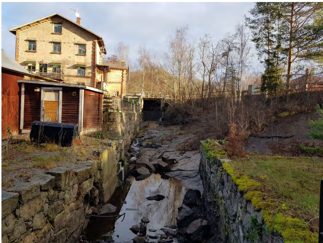
Figur 36. Den nedre delen av spillfåran vid Granefors bruk (övre) i Mieån. Här bör man höja vattennivån upp mot dammen. I den övre delen bör man gjuta en kortare slitsränna för att kunna ansluta fiskväg och damm.
