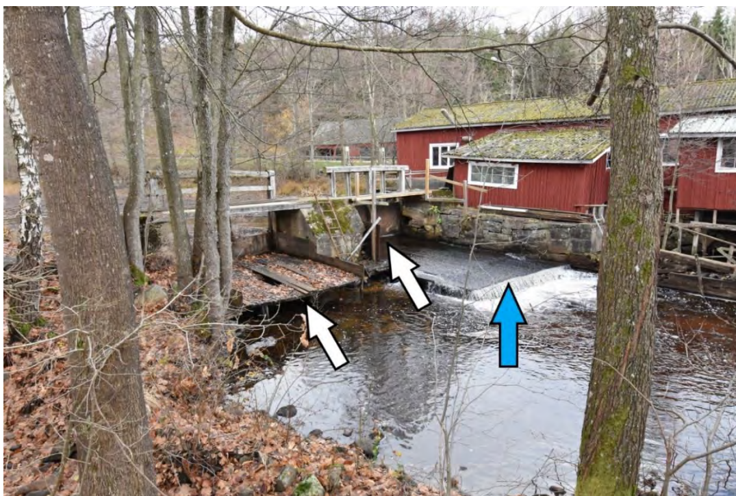
Figur 54. Jeppshoka såg i Mieån fotad från sydväst. Vita pilar: luckor, blå pil: betong. Foto: Jonathan Bark
