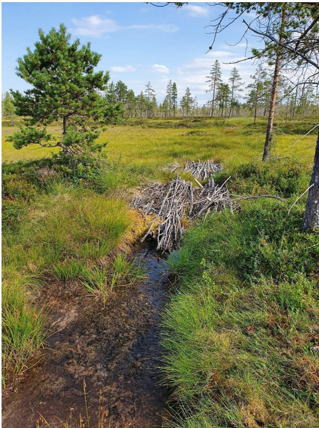
Figur 22. Igenläggning av dike cirka 15 m från rör B1, fotograferat 29 juli 2021.
