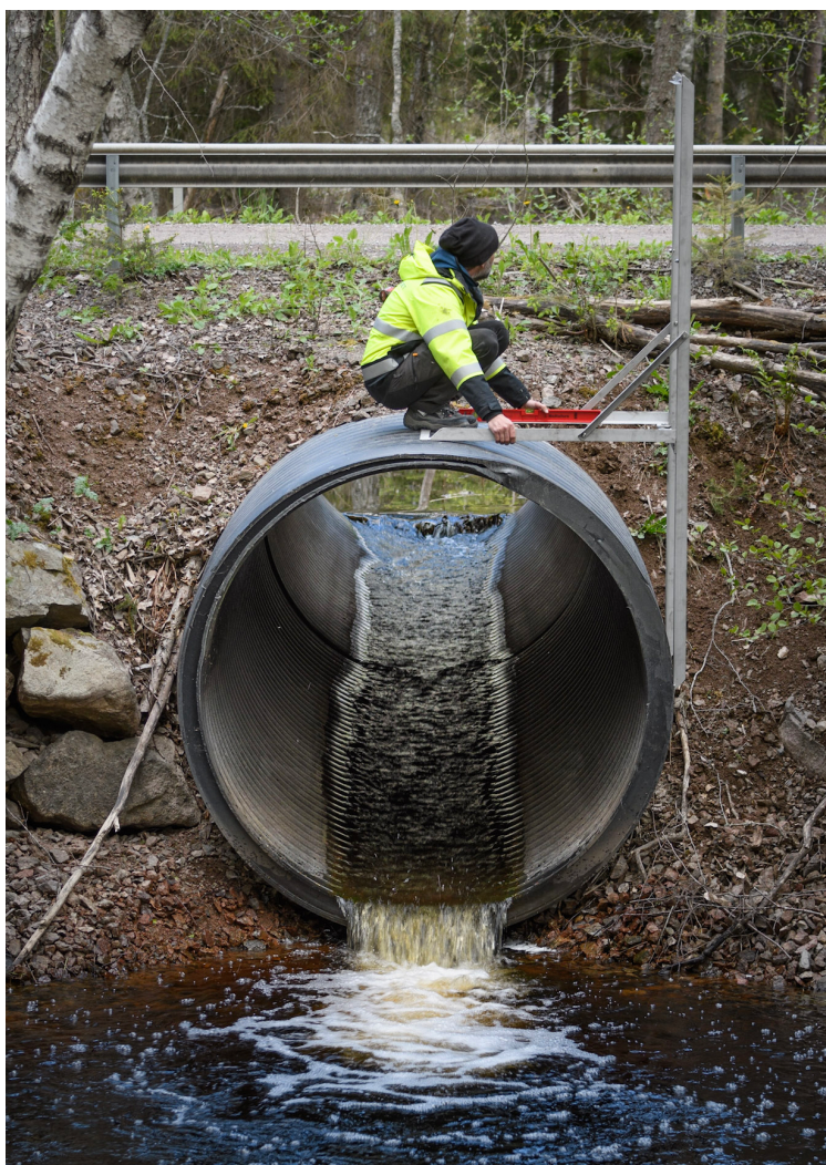
Figur 21. Foto taget på kulvertmynning på nedströmssidan. Höjdskillnaden mellan vattengång i trumma och nedströms vattenyta representerar troligen förhållanden vid MQ. Vid platsbesök oktober 2020 uppskattades höjdskillnaden till cirka 0,5 meter.
