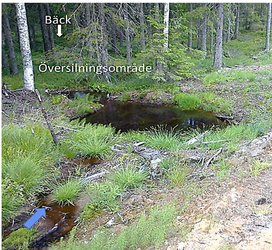
Figur 12. Slamgrop i slutet av ett vägdike vid en skogsbilväg. Bortom slamgropen vidtar ett översilningsområde på cirka 20 meter innan bäck. Foto: Elisabet Andersson
