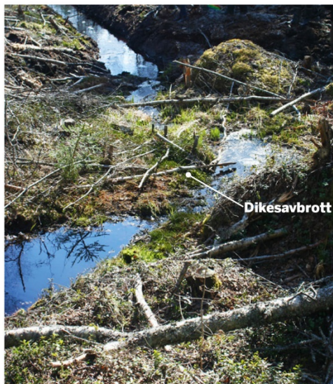
Figur 3. Genom att göra avbrott i rensningen på lämpliga ställen kan vattenhastigheten hållas så låg som möjligt. Här har de sista metrarna av tegdike lämnats orensat innan det ansluter till utloppsdiket. Den orensade sträckan kan även fungera som ett kort översilningsområde.
