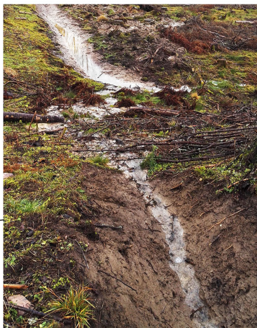
Figur 3. Ett sätt att minska transporten av partiklar är att göra avbrott och förskjuta fortsättningen på skyddsdiket. Vattnet översilar då från det ena till det andra diket.
