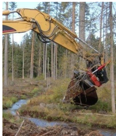
Figur 18. Här används en profilskopa för rensning av dike. Maskinen är en larvburen grävare. Foto: Anja Lomander.
