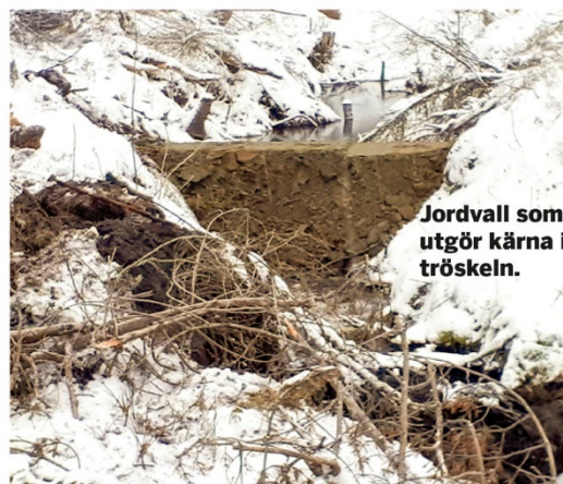
Figur 6. I detta dike har en serie av trösklar anlagts för att dämpa vattenhastigheten, vilket minskar risken för erosion i diket. Nedströms denna dikessträcka finns en sedimentationsdamm. Låg vattenhastighet gör sedimentationsdammen effektivare. En tröskel kan exempelvis göras med en jordvall (t.h.) som täcks med markduk, grus och sten.
