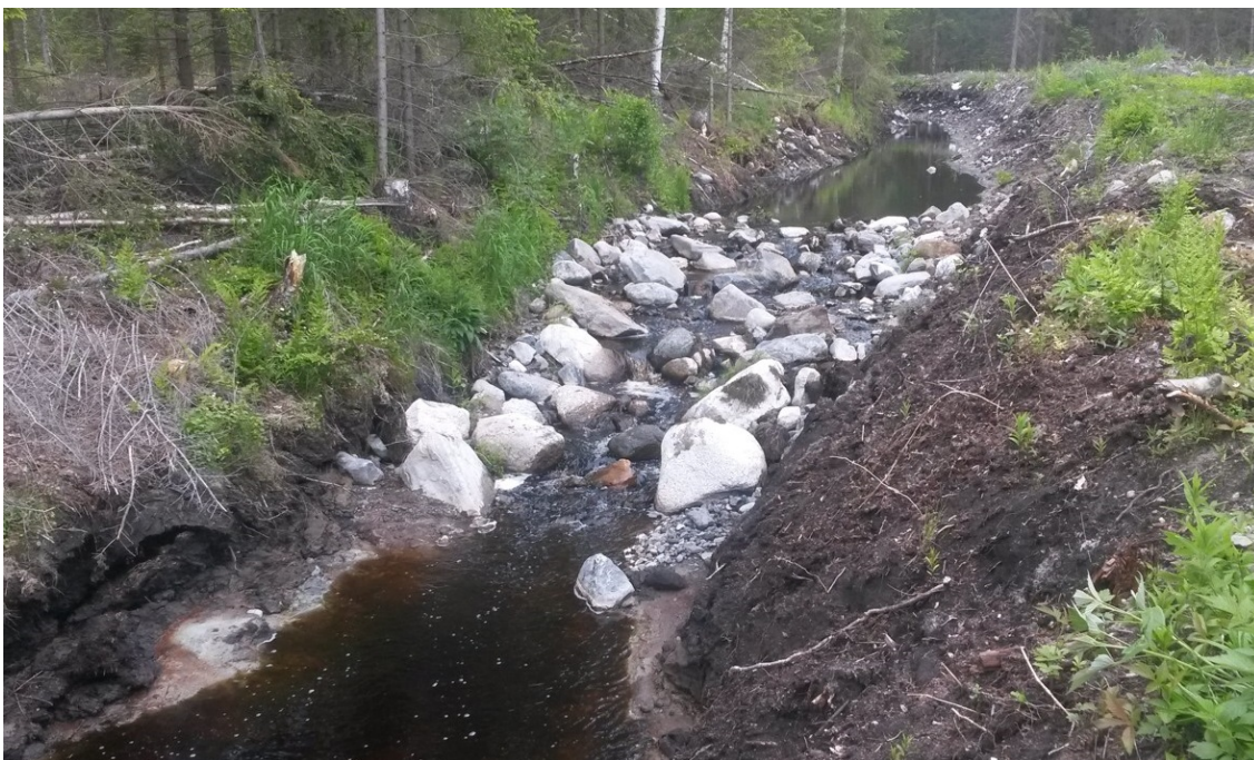
Figur 9. Tröskel anlagd i svagt sluttande sträcka av ett dike. Trösklar bromsar vattenhastigheten vilket minskar risken för erosion. De bidrar också till att skapa lite variation i stora ensartade dikessystem. Foto: Marcus Gjäl
