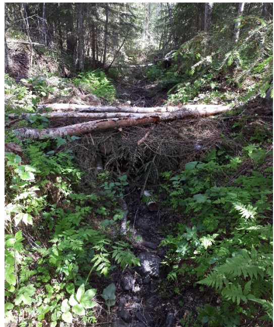
Figur 15 och 16. Exempel på enkla dikesproppar. Vänster bild: Här är virkesbitar ställda i diket. Mellanrummet har fyllts med granris och proppen har förankrats med fyra längre trädstammar som lagts på tvärs över proppen. Höger bild: En bunt med virke är lagda i diket i längdriktning. Buntarna täcks med markduk och ris. Fler och mer detaljerade tips på att konstruera dikesproppar finns bland annat i handledningen Återskapa våtmarker genom att lägga igen diken. Foto: Heine Krekula (vänster bild) och Elisabet Andersson (höger bild).
