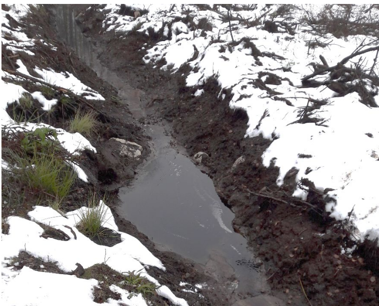
Figur 11. Liten slamgrop (slamficka) i övre delen av ett dikessystem. En slamgrop kan ha en funktion under en kort period men varje slamgrop kan bidra till att fånga en del av de grövre partiklarna och därmed minska belastningen av partikeltransporten nedströms. Foto: Eva Ring
