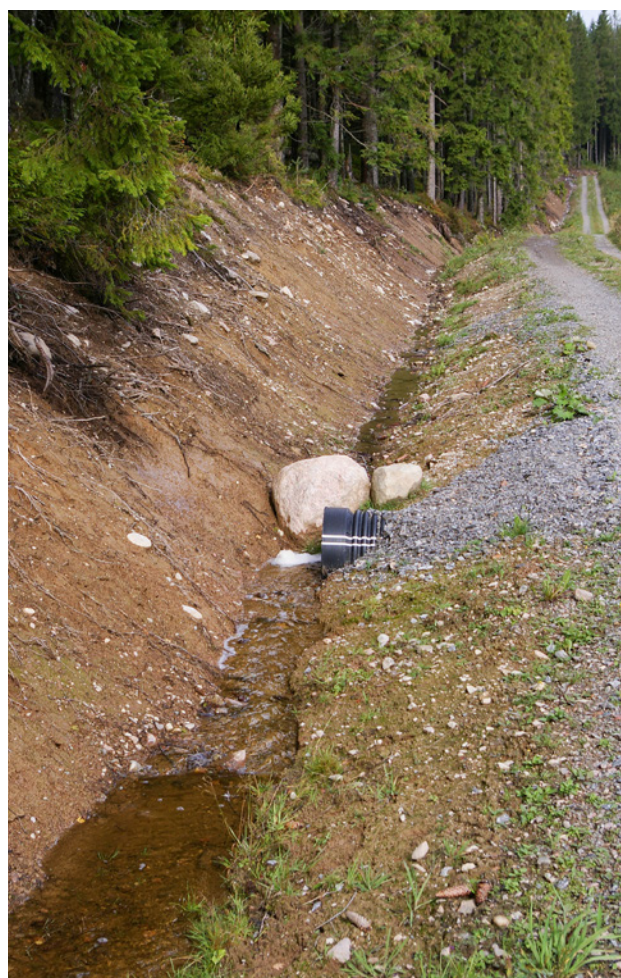
Figur 1. För att sänka vattnets hastighet i vägdiket och dessutom leda av vattnet in i trumman kan man lägga sten eller stockar i diket.
