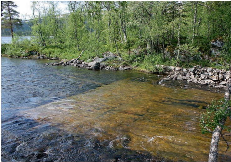
Rester etter en fløterdam i utløpet av Store Majavatnet. Dammen ble holdt på plass av store tømmerkasser, på cirka 8 x 4 meter, som var fylt med stein.
